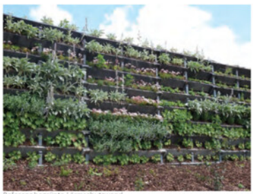
Referenz begrünte Lärmschutzwand
